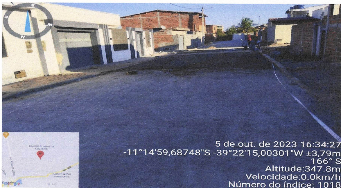
Execução de Pavimentação da Cantinho da saude Rua 03
