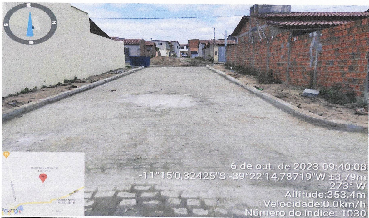
Execução de Pavimentação do Cantinho da saude Rua 07
