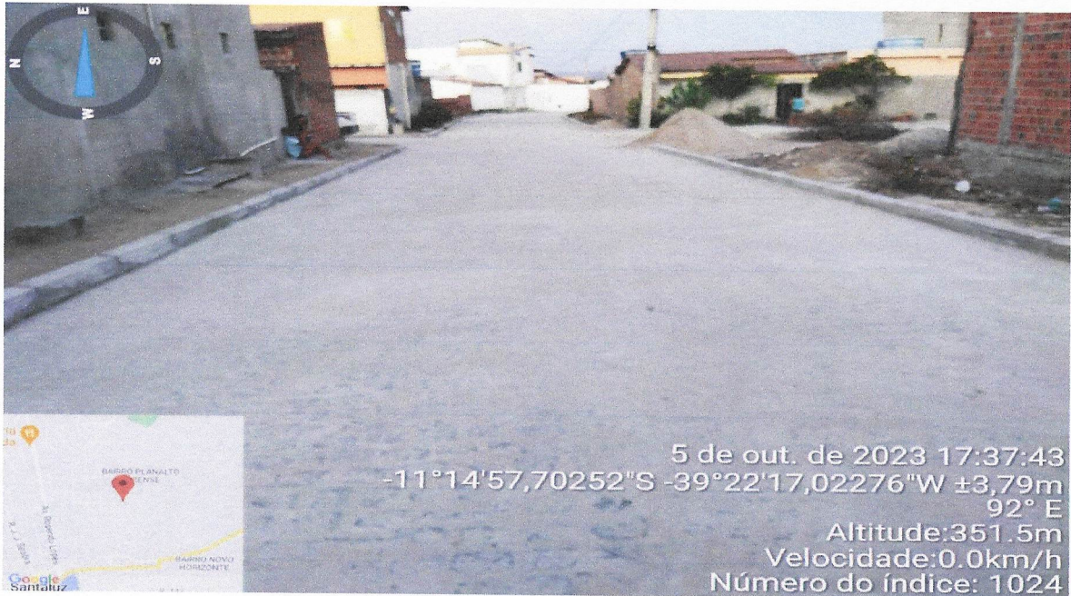
Execução de Pavimentação da Cantinho da saude Rua 01
