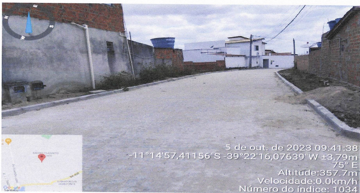
Execução de Pavimentação da Cantinho da saude Rua 02
